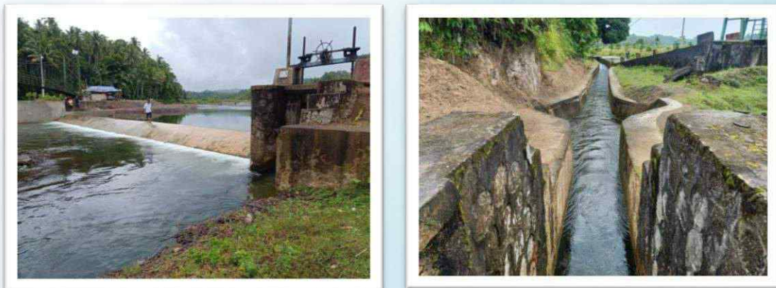
Gambar 3.16 Rehabilitasi Daerah Irigasi Duku Sp. 1 Kecamatan Sungai Limau
