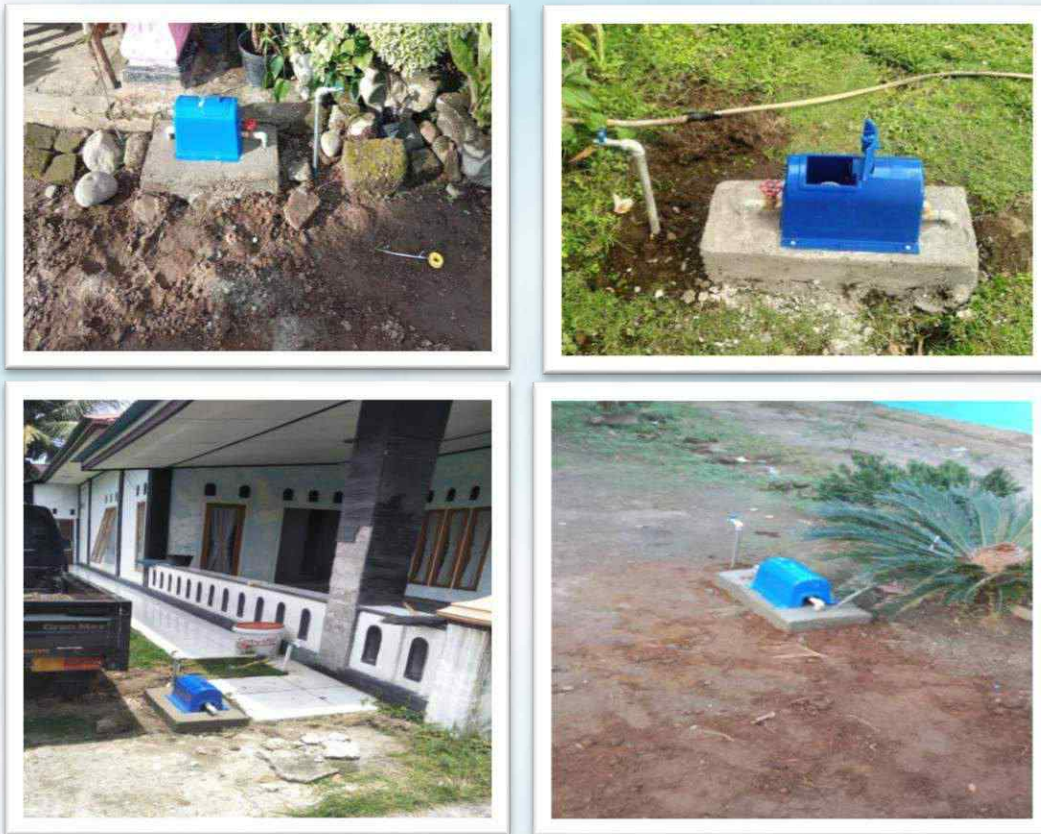
Gambar 3.135 Pembangunan Jaringan SPAM Jaringan Perpipaan Kawasan Pedesaan
