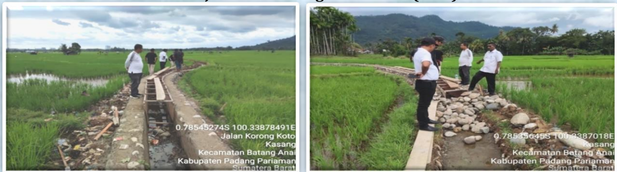
Gambar 3.8 Pekerjaan Daerah Irigasi Maransi (DAK)
