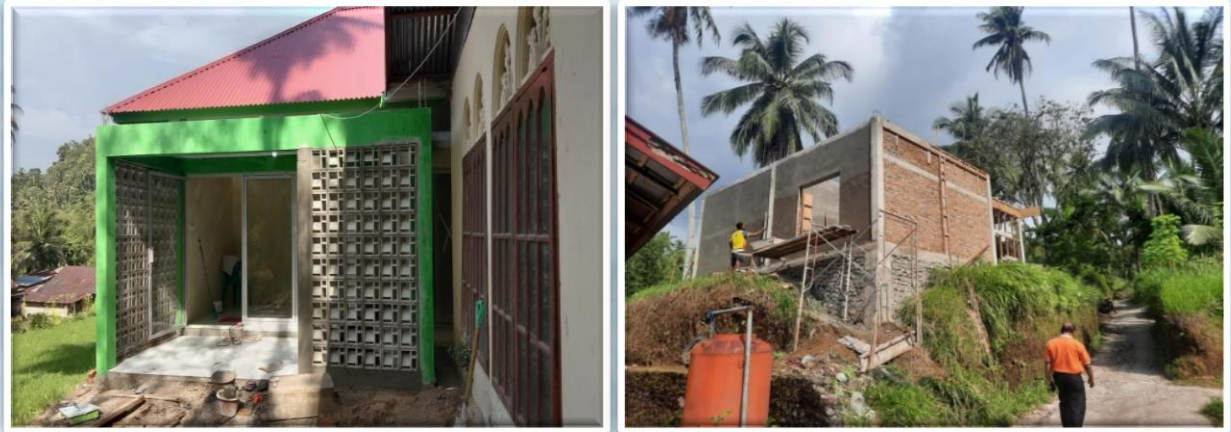
Gambar 3.47 Pembangunan Perpustakaan Nagari Kudu Gantiang Barat
