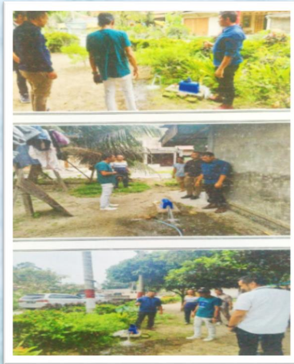
Gambar 3.120 Pembangunan SPAM atau Peningkatan SPAM di Nagari Sunua
