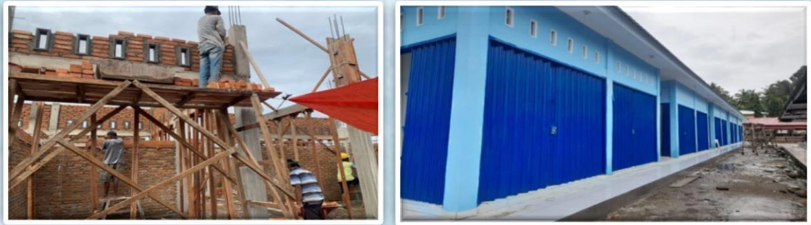
Gambar 3.13 Pembangunan Pasar Rakyat di Pasar Pakandangan
